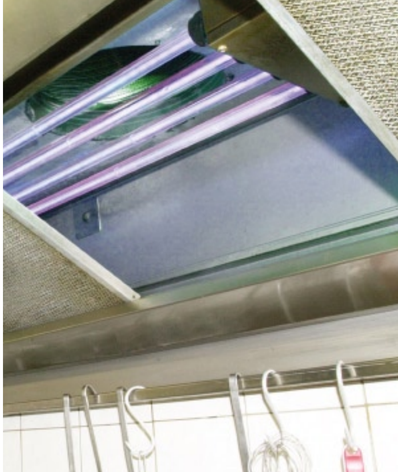
Kalte Verbrennung von Fetten in einer Küchenabzugshaube
